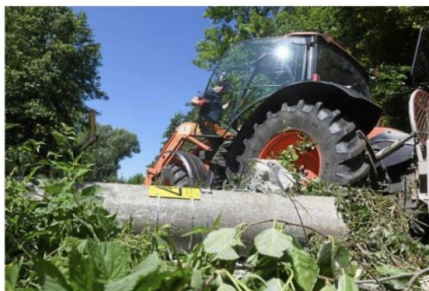
Einer der beiden Betonmasten wurde durch das Gewicht des Baumes komplett umgehauen.
