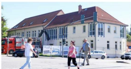
Noch sieht das Gebäude an der Hauptkreuzung so aus. Ab Montag wird sich der Anblick ändern, dann beginnt der Teilabriss des rechten Flügels.
